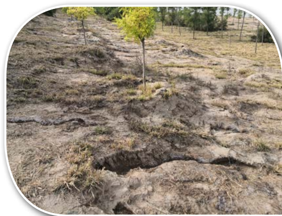
图1-3 堤岸边坡水力侵蚀
