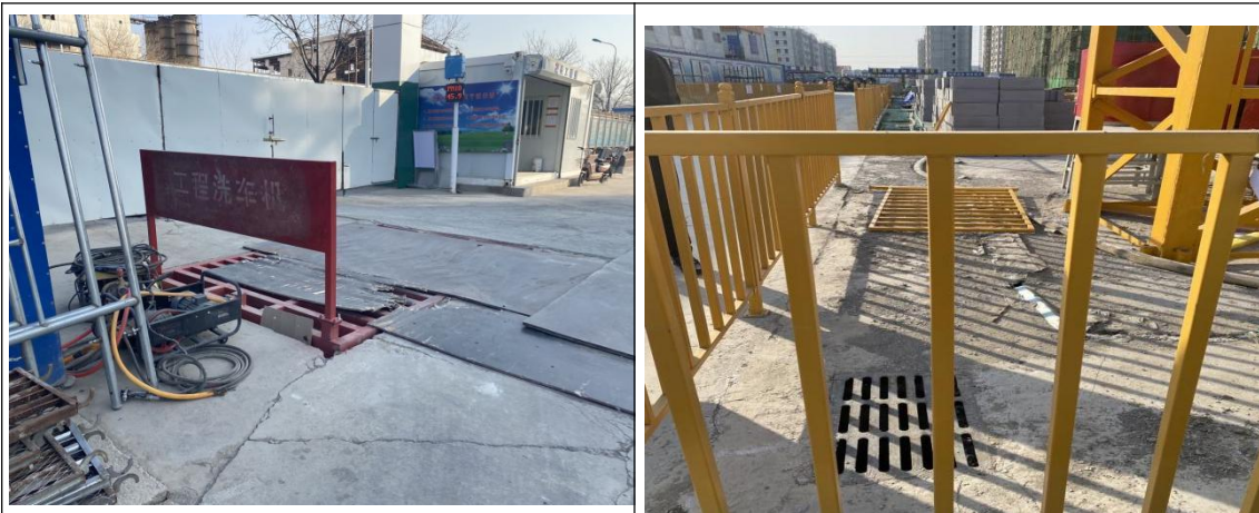
施工期临时措施
