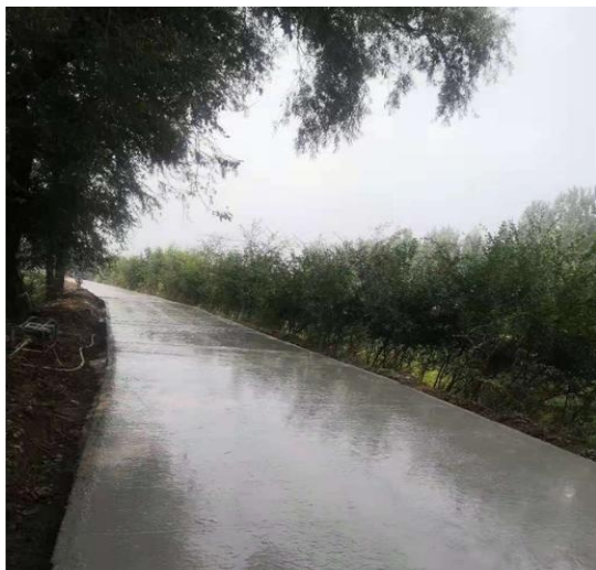
混凝土路面浇筑
