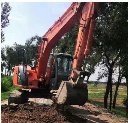
堤顶道路清基
