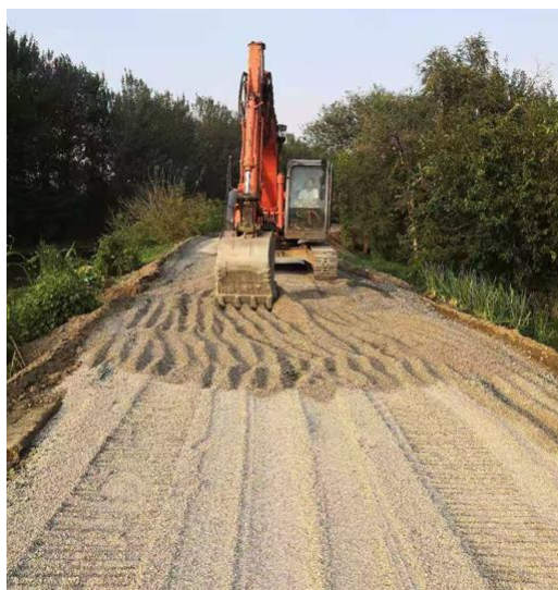
碎石屑基层铺设
