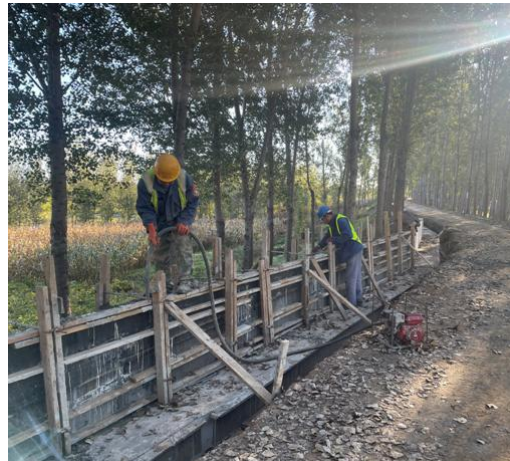
混凝土防浪墙浇筑
