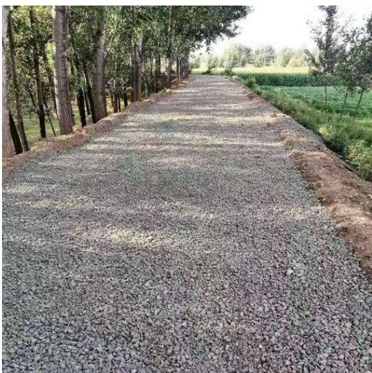
碎石底基层铺设
