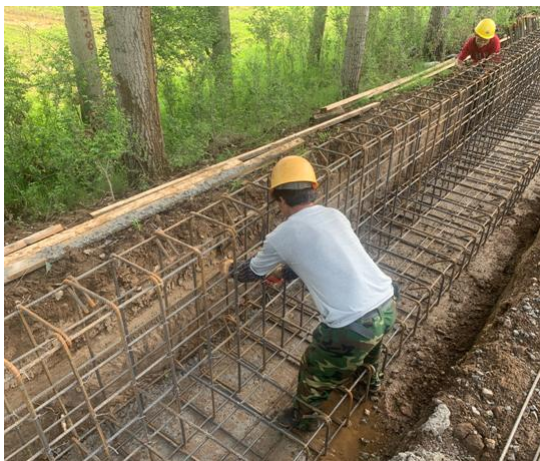
混凝土防浪墙钢筋绑扎
